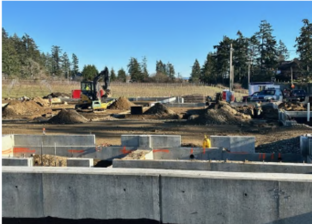
Jan. 27, install of elctrical conduits
